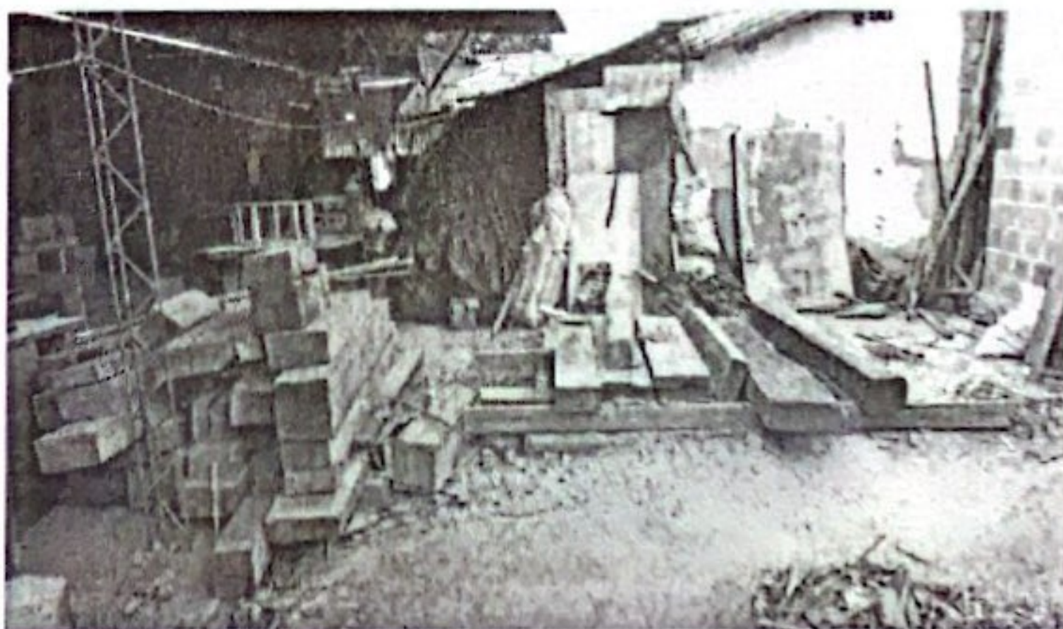
Estructura de las instalaciones, madera en el depósito y oficina
