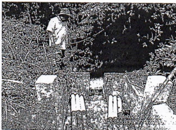
Conexión desde el canal hacia manguera de conducción.
