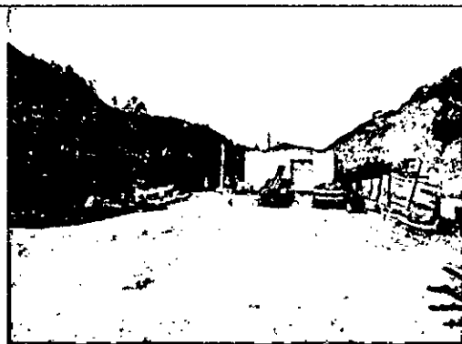
Foto No. 2 Proyecto PTAR Peaje
