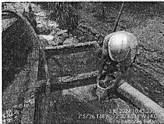
Punto de llegada agua residual – aforo de caudal
