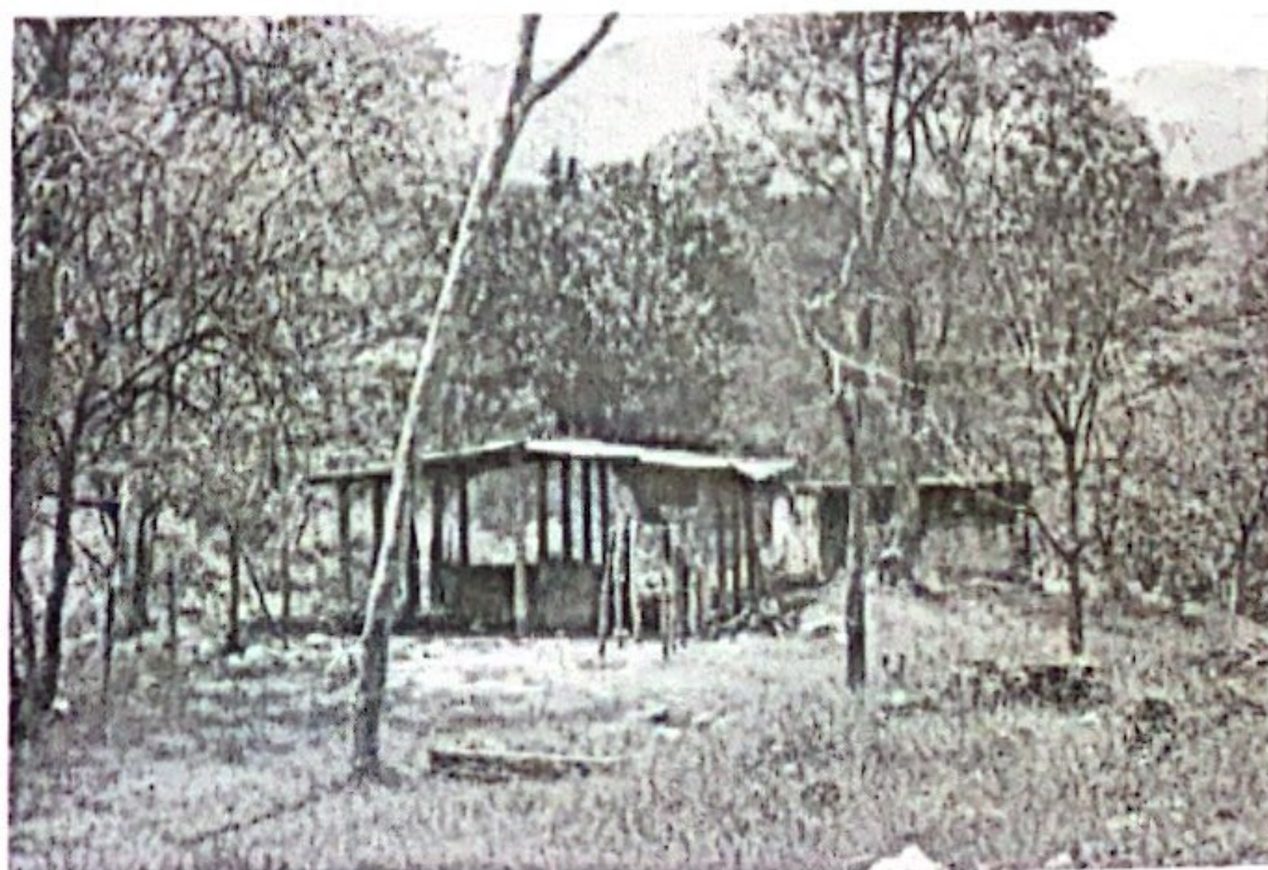
Localización de aarboles sobremaduros y establo a recuperar.
