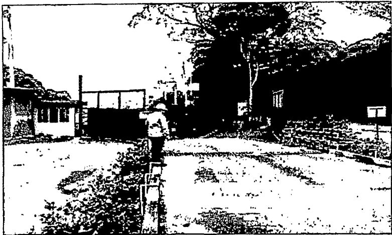
FOTO NO. 1 ENTRADA A LAS INSTALACIONES DEL CENTRO DE ACOPIO
