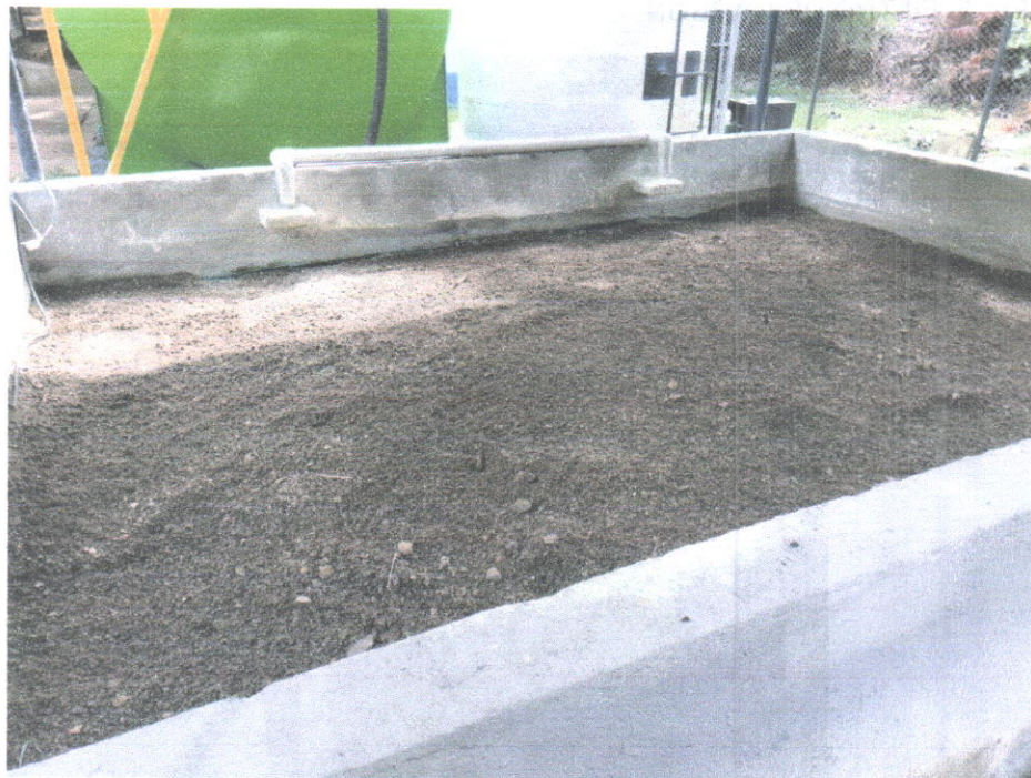
FOTOGRAFÍA 3. TRAMPA DE LODOS
