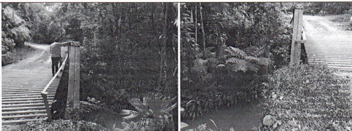
Puente Socuavó II: Pr22+350 - 8°38'11.59"N, 72°53'6.89"W
