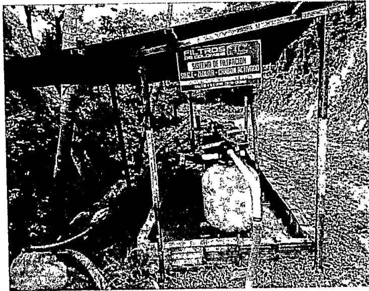
Fotografía 11. Tanques de almacenamiento de distribución en el casino y campamento.
